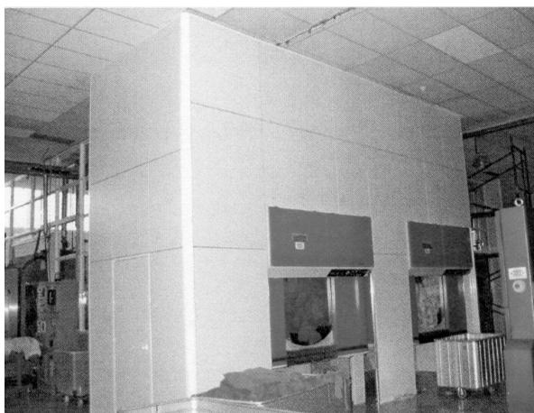
**Tabla III. Medición después del apantallamiento para disminuir el ruido de las secadoras. Agosto, 2003**
